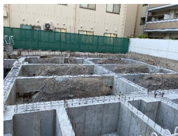
基礎工事(5月末)
